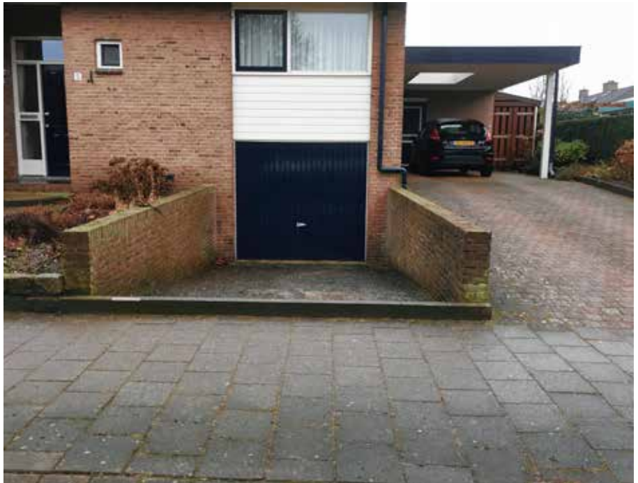
Op de overgang van de afrit naar een souterrain en de weg moet eigenlijk een 'drempel' liggen. (Foto's: Stichting Rioned)
